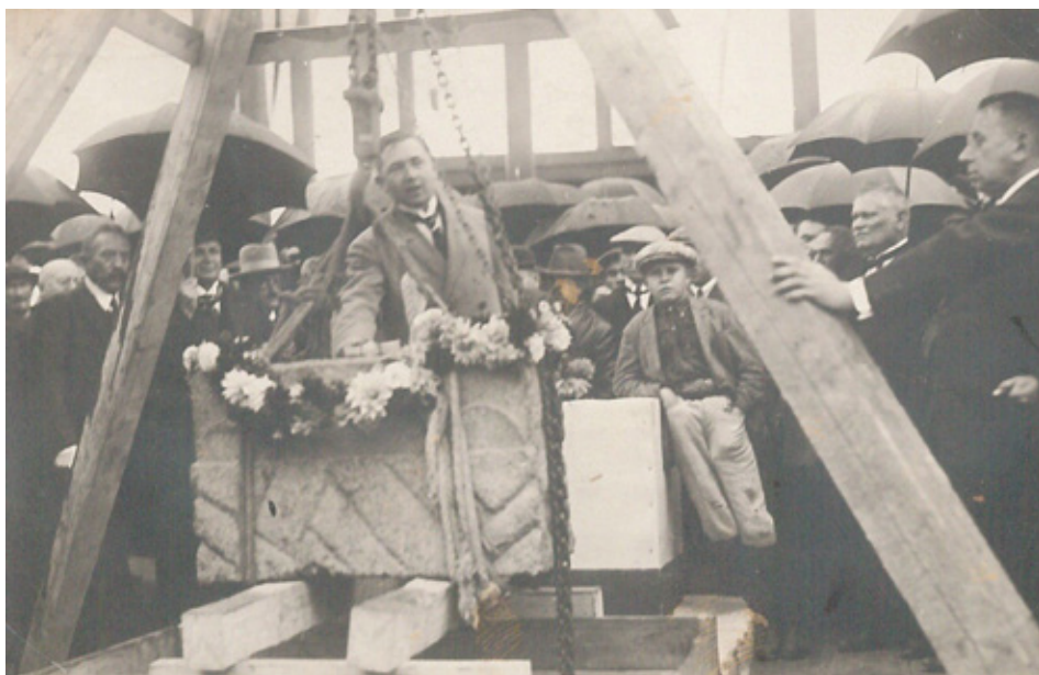
Obr. 3. Slávnostné kladenie základného kameňa budovy ŠÚPZŽ. Poklep A. Urbana, vpravo rukou opretý o trám minister Ing. L. Novák. Archív SNM, pobočka v Martine Fig. 3. Celebrations for the laying of the foundation stone of the ŠÚPZŽ building. Cornerstone laid by A. Urban, Ing. L. Novák on the right, his hand resting on a beam. Archives of the SNM, Martin branch
